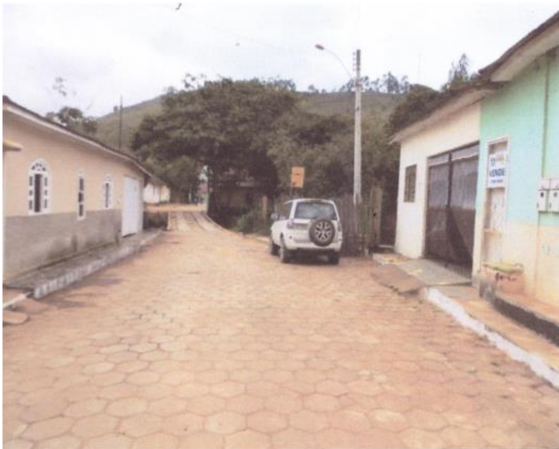
Foto 3: Região onde a inundaç o chega a aproximadamente 1 metro.
