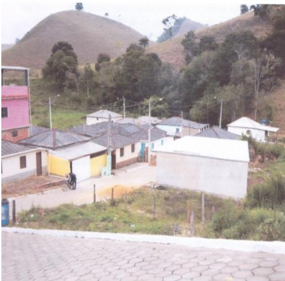
Foto 7: Moradias à margem do Rio Veado.
