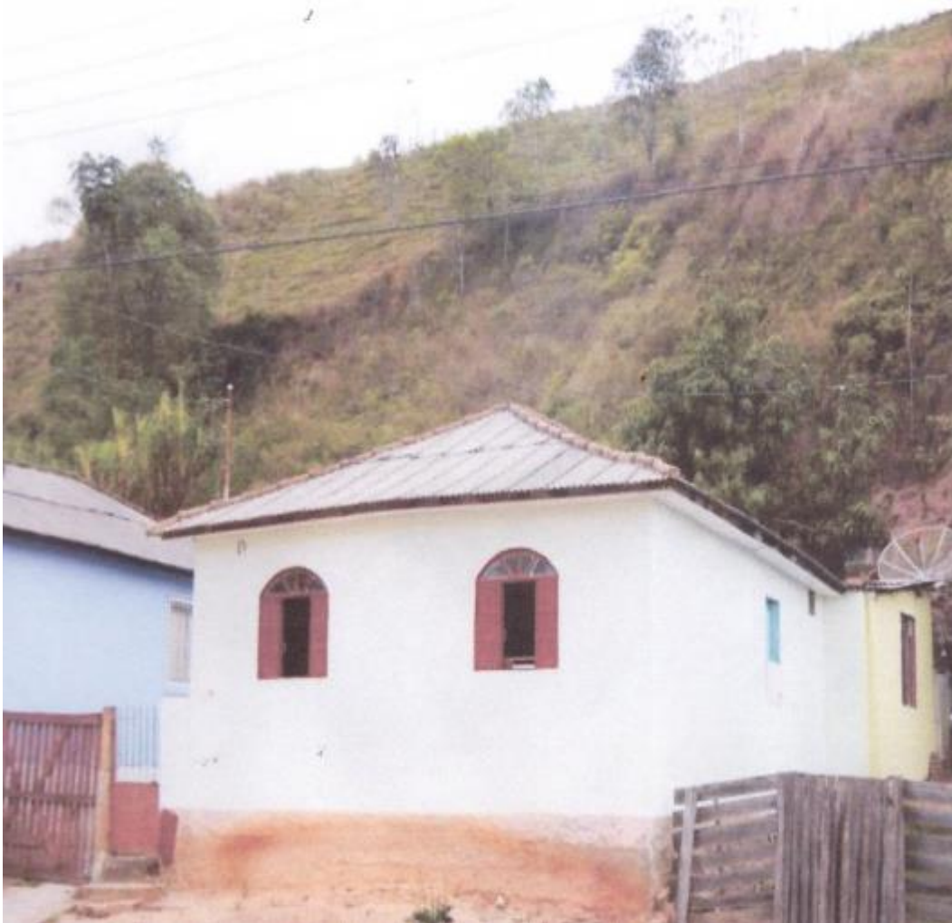
Foto 1: Um dos imóveis atingidos por deslizamentos em 1989.
