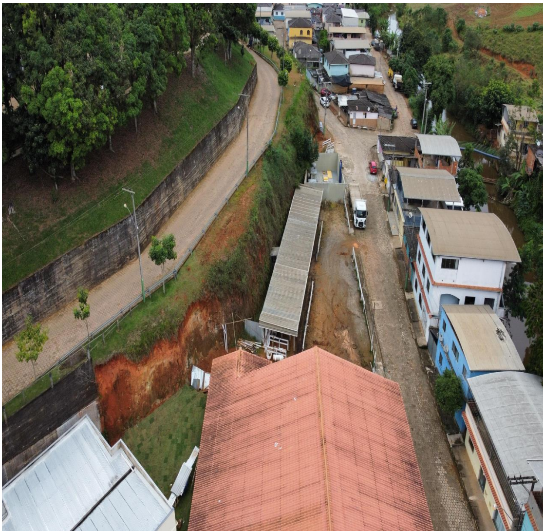
Foto 09: Muro de contenção ao lado do CRAS.
